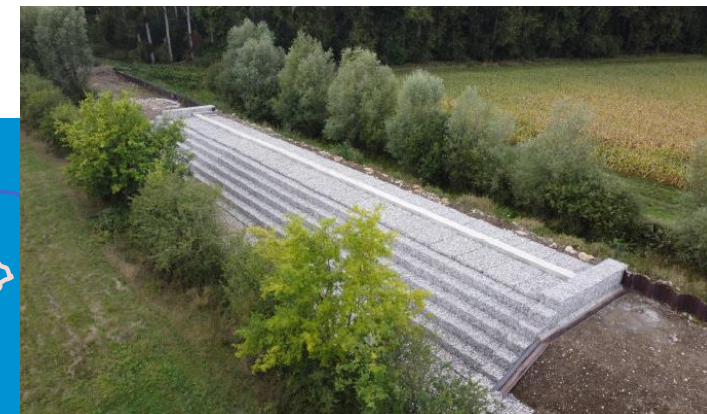
Figure 4-2 : Vue du déversoir de crues de la digue de Marizelle
